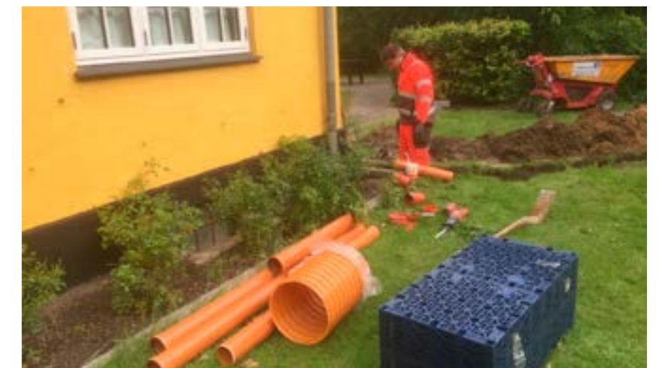
Etablering af nedsivningsanlæg på præstegården i 2017 (foto: Niels Andersen)
