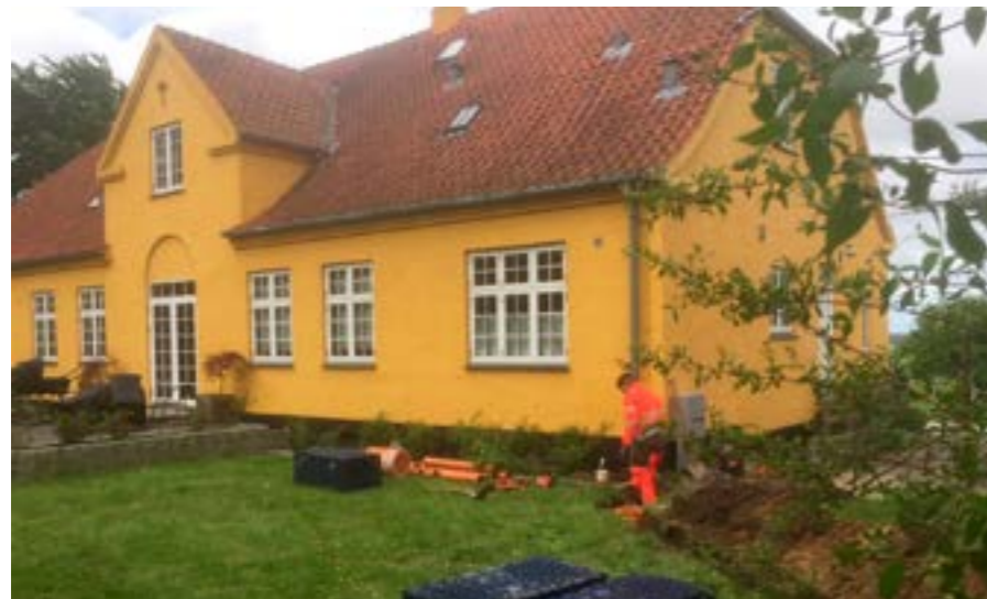
Etablering af nedsivningsanlæg på præstegården i 2017 (foto: Niels Andersen)
